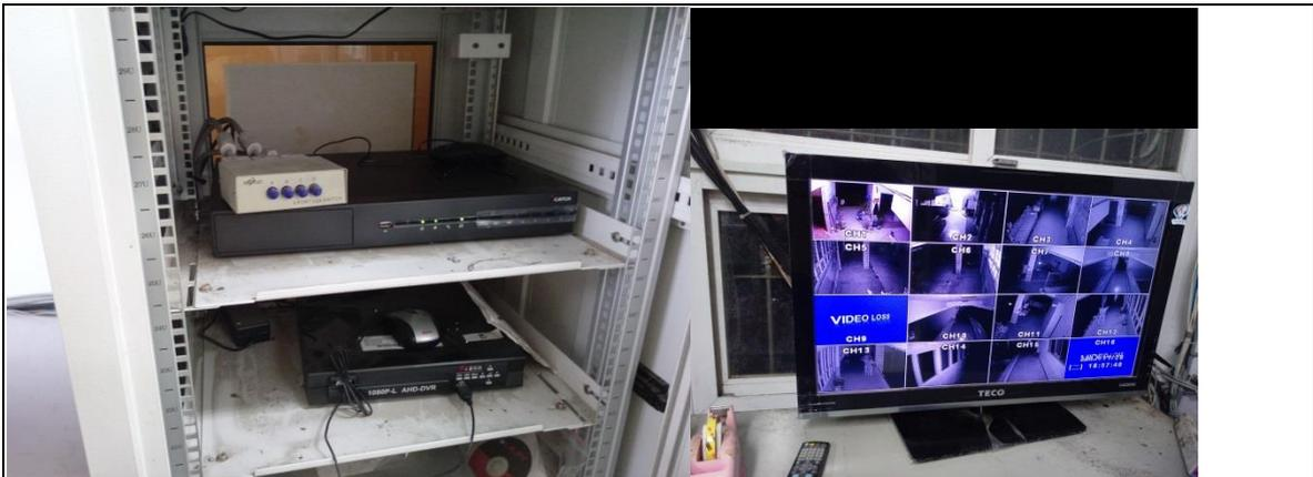
說明：總務處舊主機升級及鏡頭修復及線路更新可取 16 路 DVR 主機及 16 鏡頭（部分鏡頭因修業樓耐震補強需等工程後再復原）
